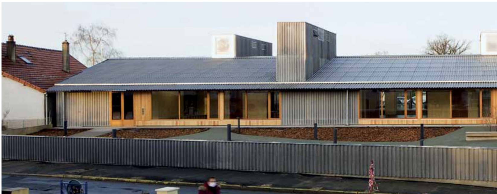
Côté rue, le bâtiment s'affirme comme bioclimatique avec ses trois cheminées de ventilation naturelle; il a deux entrées distinctes, pour l'école et le périscolaire.
