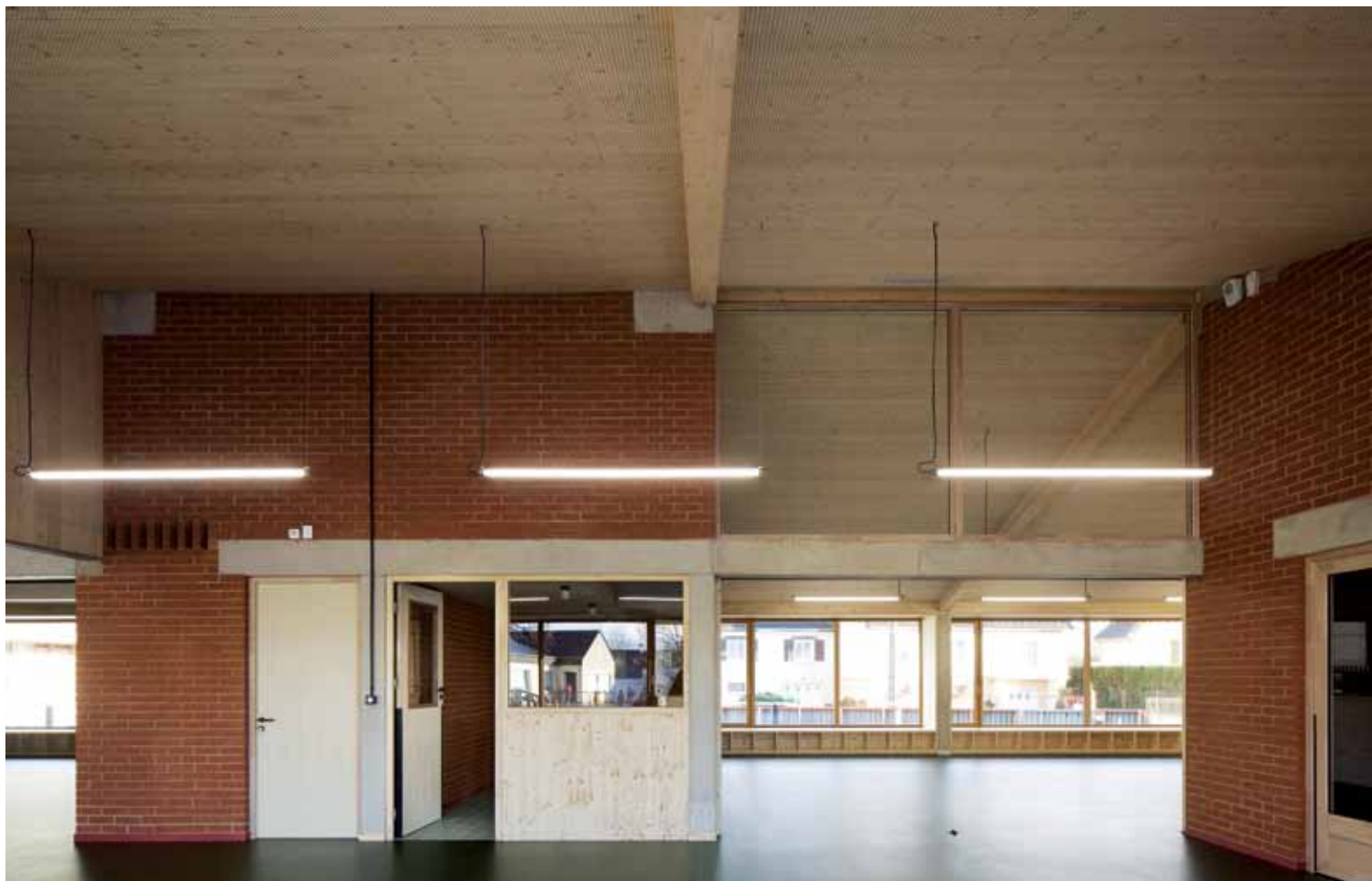
Les blocs de maçonnerie permettent de libérer de grands volumes (entre 60 et 80 m 2 ), baignés de lumière et divisibles au moyen de cloisons légères.
